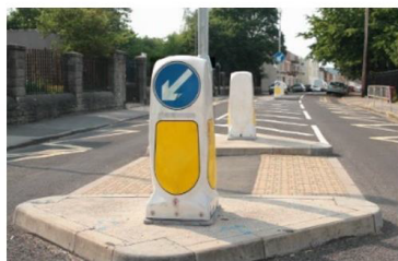
Защищенные островки безопасности на пешеходных переходах
