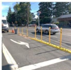
強化中央線 / 轉彎硬化
