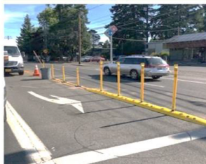
Дополнительное обустройство разделительной полосы, а также на поворотах для снижения скорости
