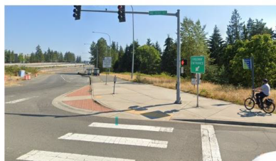
Повышенный бордюр для увеличения радиуса движения грузовых автомобилей
