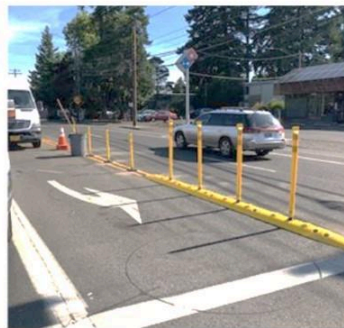
Vạch kẻ cứng và gờ giảm tốc ở giữa làn đường và tại chỗ rẽ
